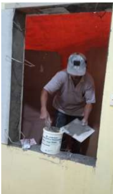
Verbouwing van de ruimtes
