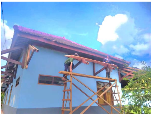
Verbouwing gebouw 1 van opslag naar woning
