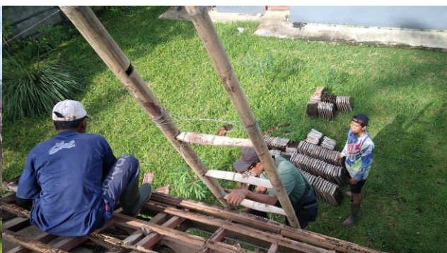
De pannen en het hout worden verwijderd
