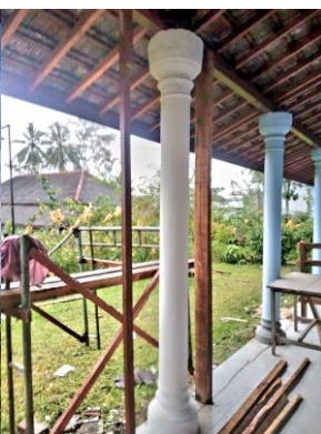
Renovatie gebouw 3: hout wordt vernieuwd, de overkapping wordt uitgebreid, nog even poetsen en het resultaat
