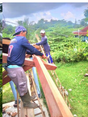
Het hout wordt vernieuwd
