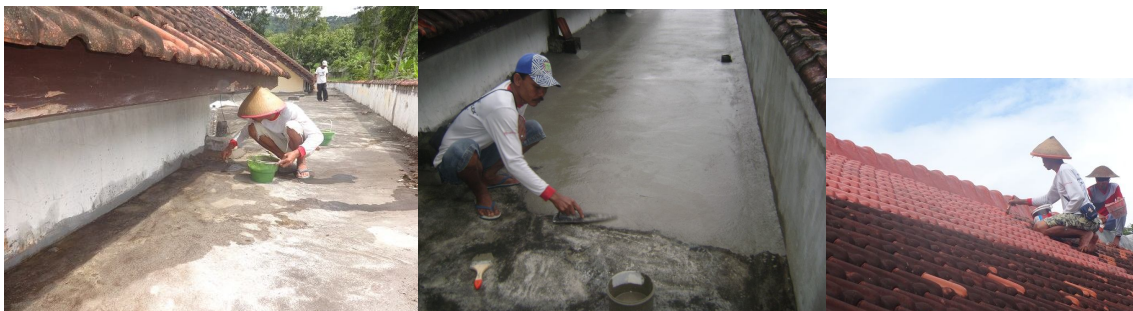
Renovatie van het dak: lekkages worden gerepareerd en de pannen krijgen een coating
