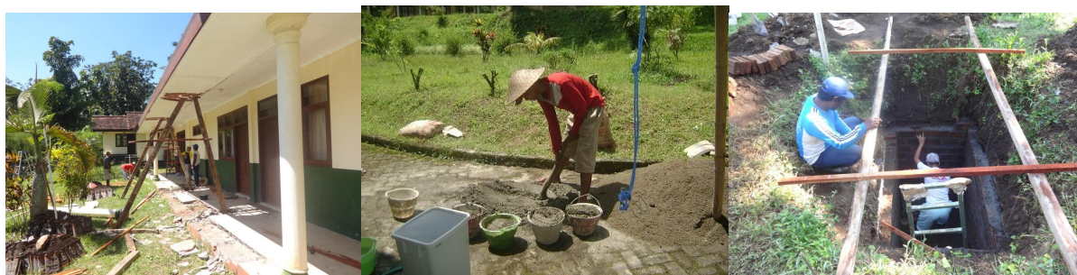
De verzakking van het bijgebouw wordt gerepareerd, cement wordt met de hand gemaakt, en de septitank wordt ook hersteld
