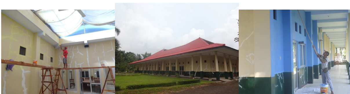
Scheuren worden gerepareerd en daarna wordt alles geverfd
