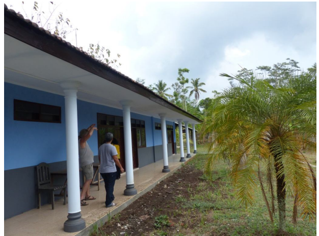
De verzakking van de paviljoens is gerepareerd
