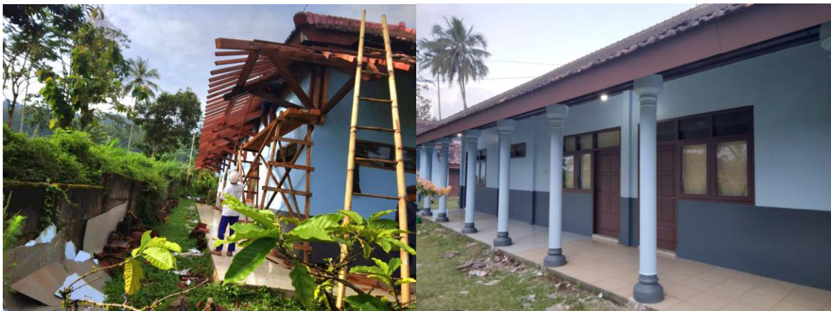
Renovatie van de bijgebouwen
